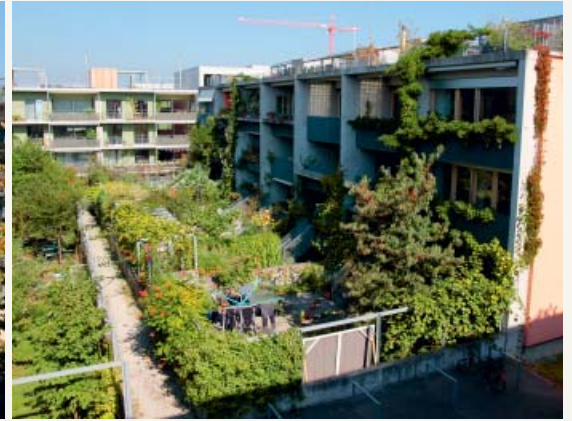
Siedlung Baumgarten Bern: Ein differenziertes Raumangebot mit Gemeinschaftshof und interner Erschliessung (Bild links) sowie Privatgärten und Fusswege (rechts)
